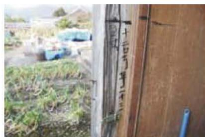
写真 3 アガリヤ I の浸水位置印
